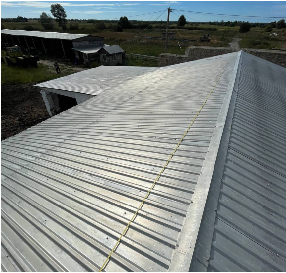
Покрівля об'єкта, металопрофіль · вересень 2026
